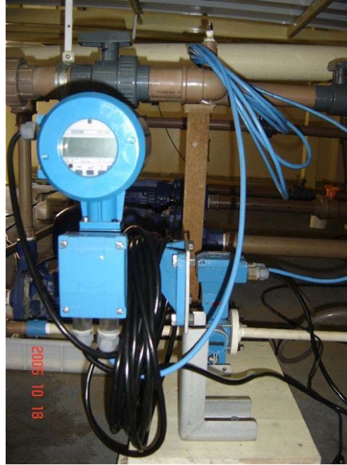
Figura 6. Medidor magnético de vazão.
